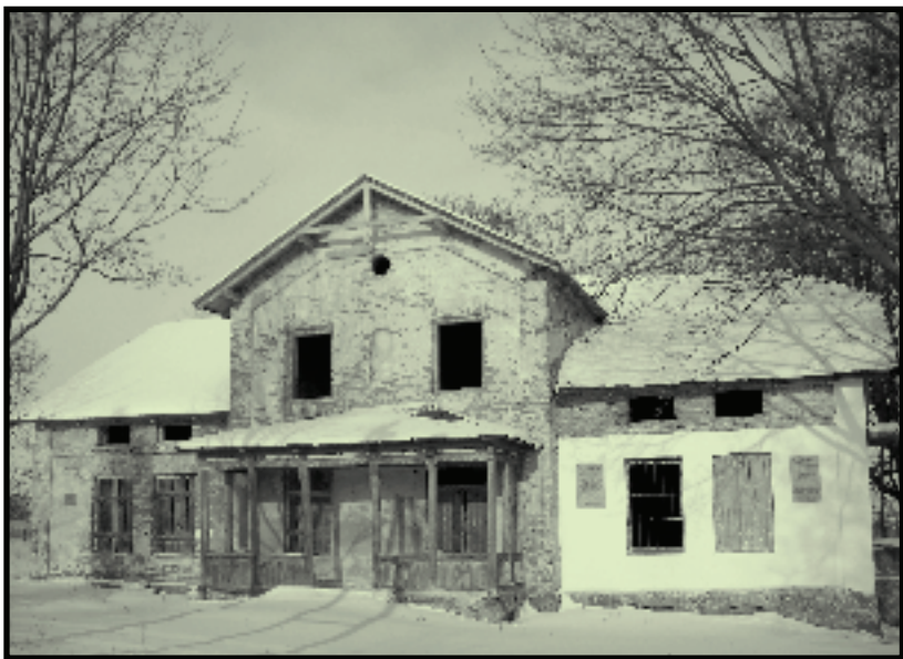
Dwór w Szczukach po remoncie – ma nowy dach i jest zabezpieczony przed popadaniem w ruinę.
