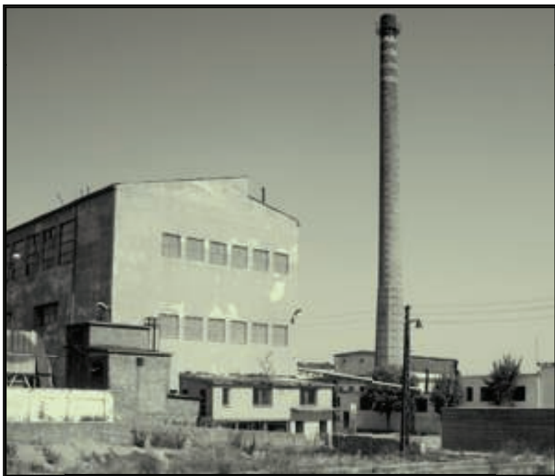
Cukrownia „Krasiniec” już nie funkcjonuje, ale komin ocalał.
